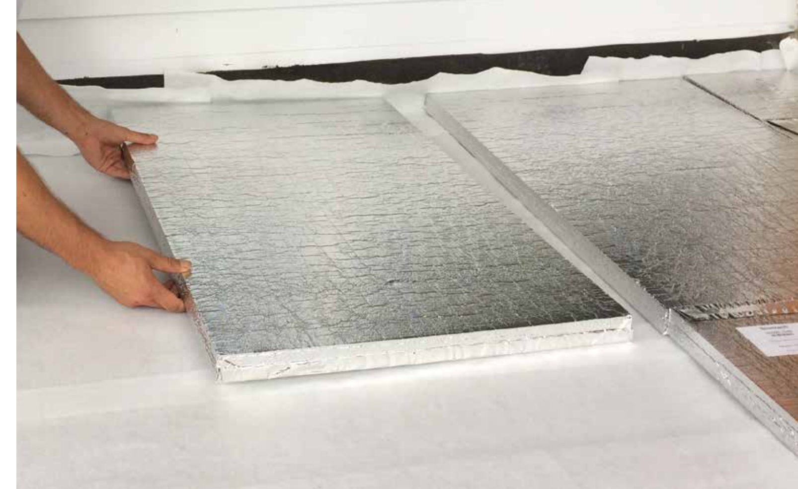
Verlegung von Vacuboard für Balkonaufbau.
